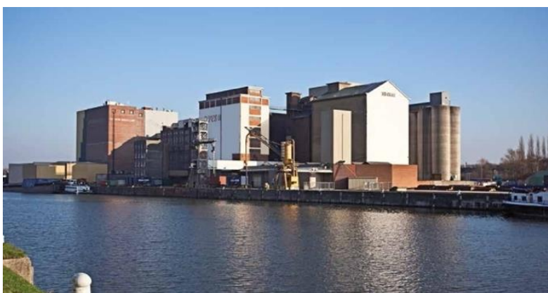
Figure 26 Meunerie Ceres - Le long de la rive est du canal, Port de Bruxelles.
